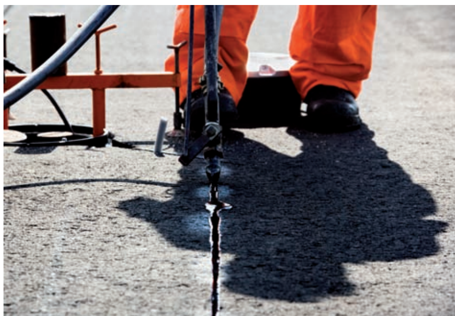
Vullen sleuven voor kabels
