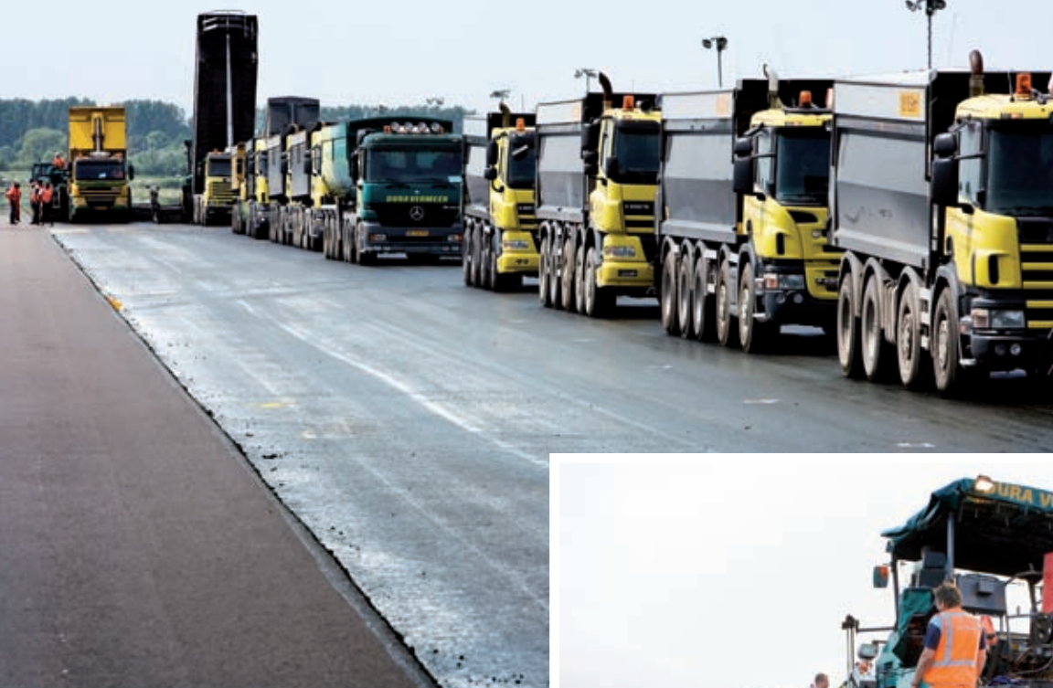
Aanvoer asfalt van de ACR, APM en reservemolen ARA
