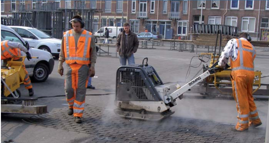
Aanleg Streetprint op het Afrikaanderplein.
