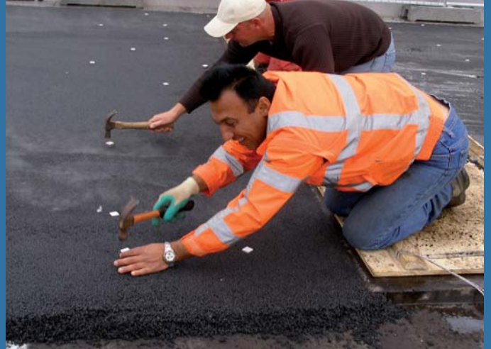
Aanleg flonkerende sterren in extra zwart asfalt.
