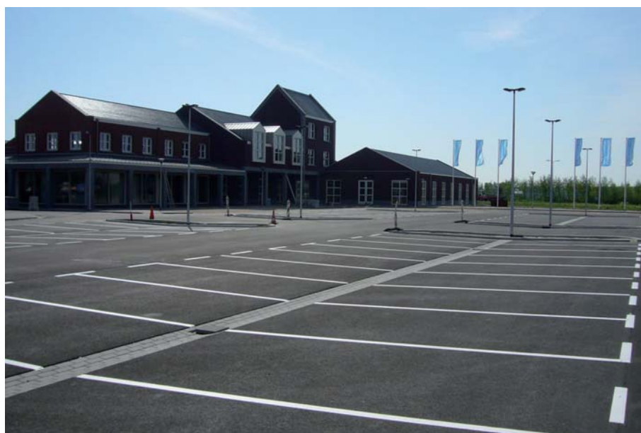
Het ruim 30.000 vierkante meter grote parkeerterrein in Middelharnis speelt een belangrijke rol in het duurzaam energiesysteem op het bedrijventerrein.
