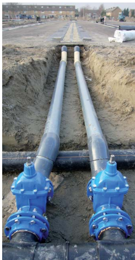
Aanleg van buizen.
