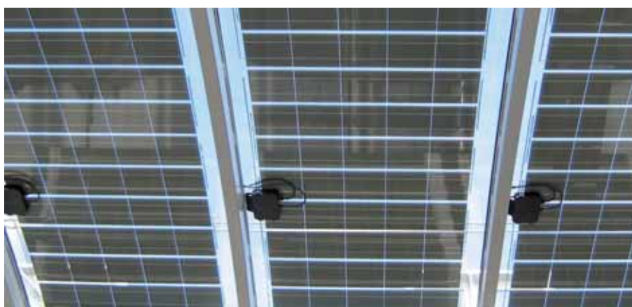
Koudgebogen gelaagd glas met zonnecellen.
