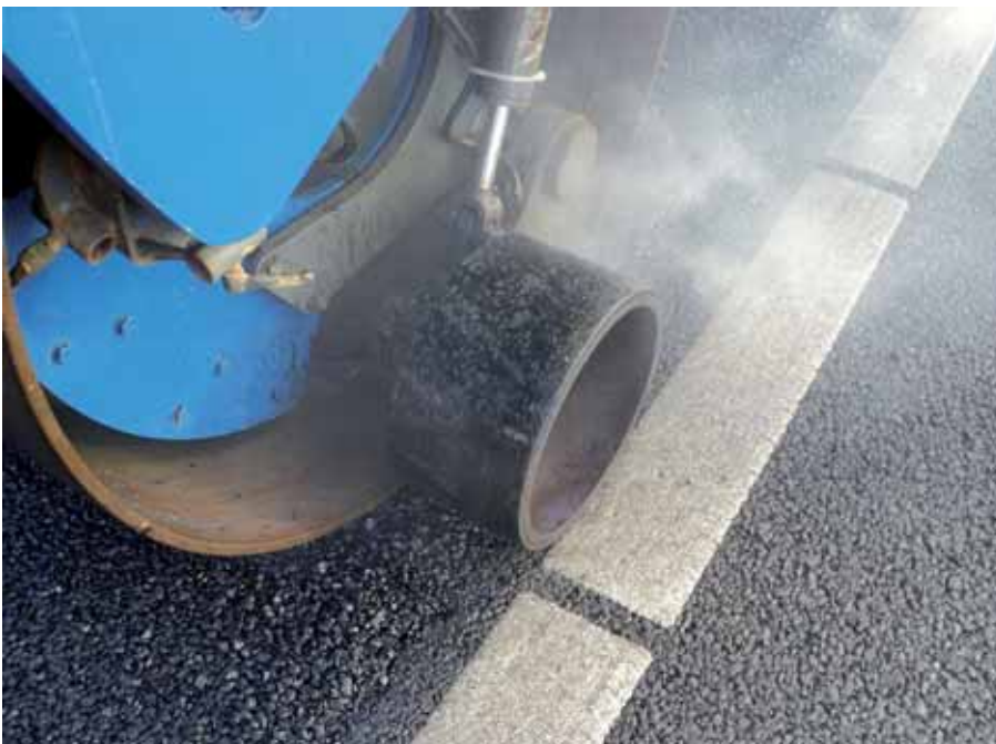
Detail walsrol op aansluiting nieuw en bestaand ZOAB.
