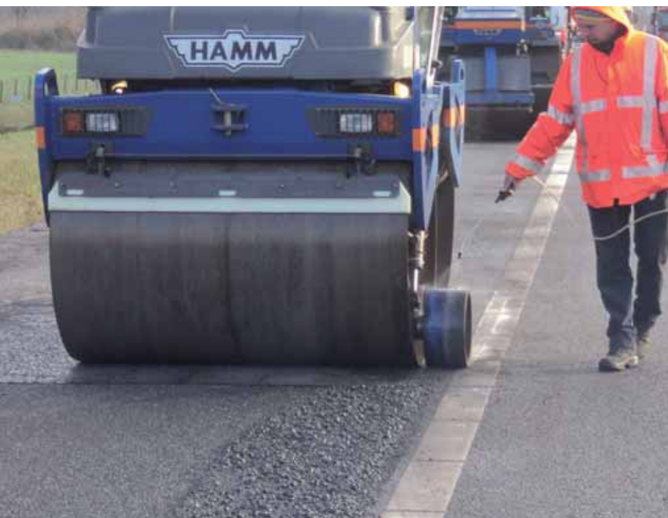
Uitvoeringsmethode KWS met walsrol op de A35 met antiplakmiddel.
